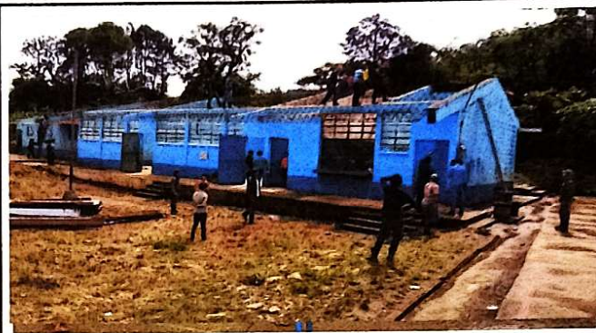
Foto 2: Limpieza general de edificio
