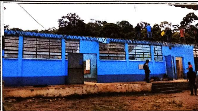
Foto 1: Levantado total de lamina y limpieza de estructura
