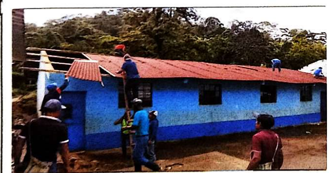
Foto 5: Descombramiento módulo dos
